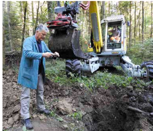
Bilder vom 15. September 2020, wo im «Buechwald», auf ehemaligen Kehrichtdeponien, Sondierungen (Baggerschlitze) durchgeführt wurden.
