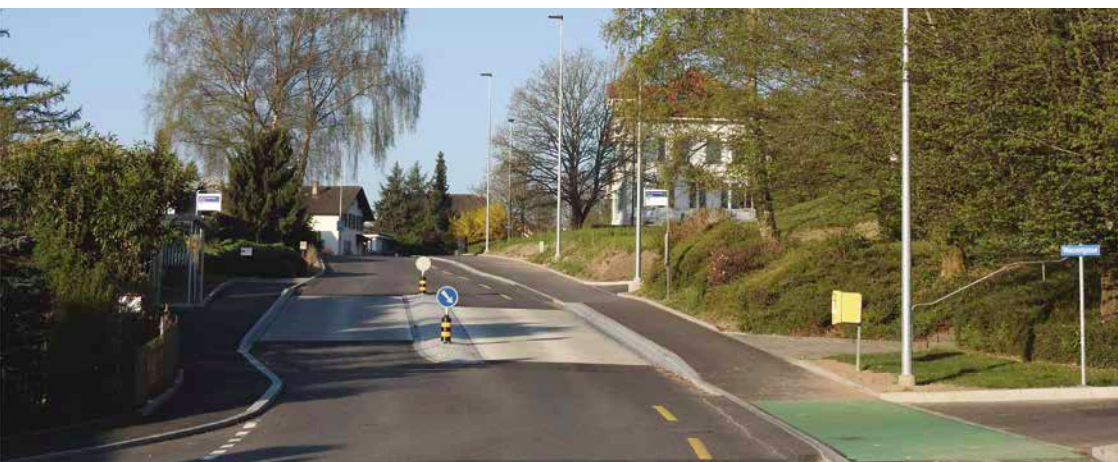
Das grösste Projekt der vergangenen Legislatur ist sicherlich die Sanierung der Schulhausstrasse. Foto: Lu
