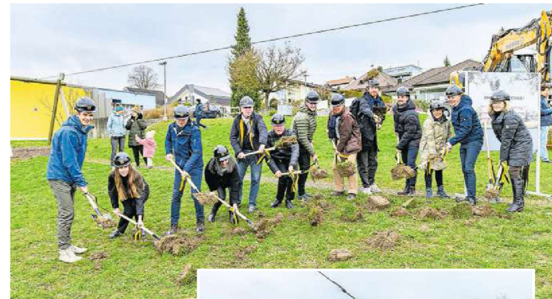
Freude herrscht: Am Spatenstich mit dabei sind Gemeinderätinnen und Gemeinderäte, die Verwaltung, die Beteiligten vonseiten der Schule, die Unternehmer, Planer und Architekten.
