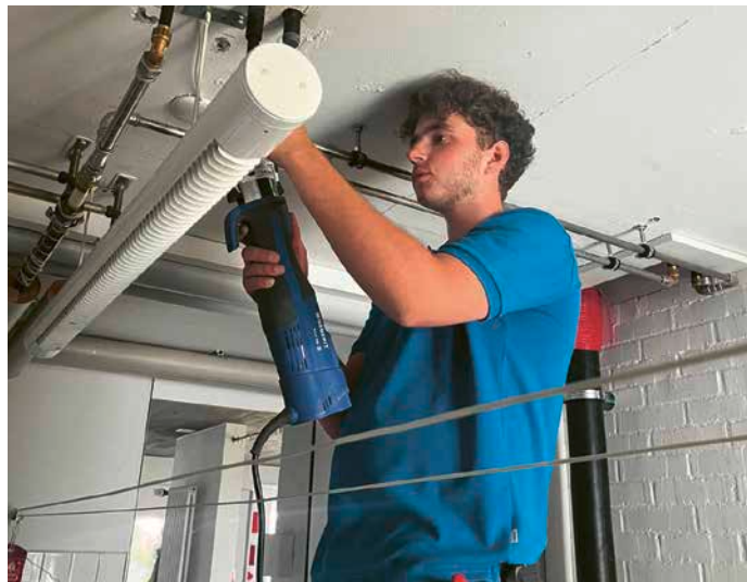
Verbauen von Trinkwasserleitungen.
