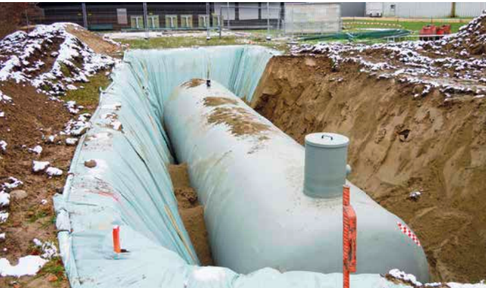
Der über 16 Meter lange Tank wurde beim Schützenhaus eingegraben. Foto: rb
